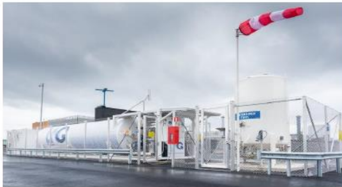
Fixed LNG & LCNG fueling station
