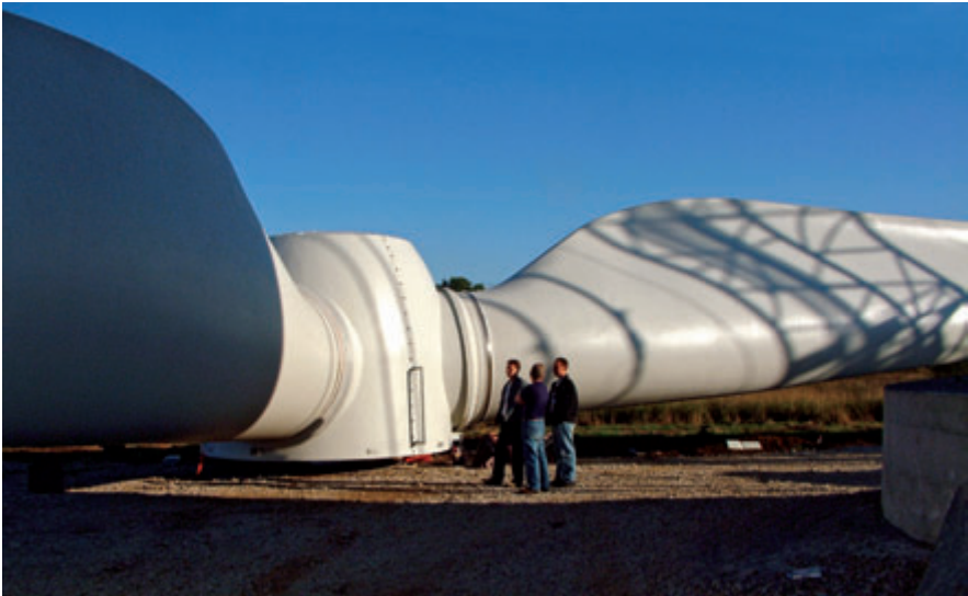
Viru-Nigula tuulepargi tuuliku tiivik ootab ülestõstmist (11.09.2006)
