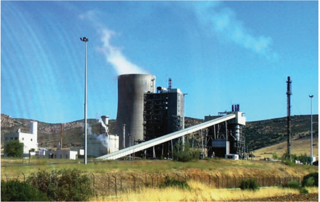
Puertollano elektrijaam, Hispaania 2009
