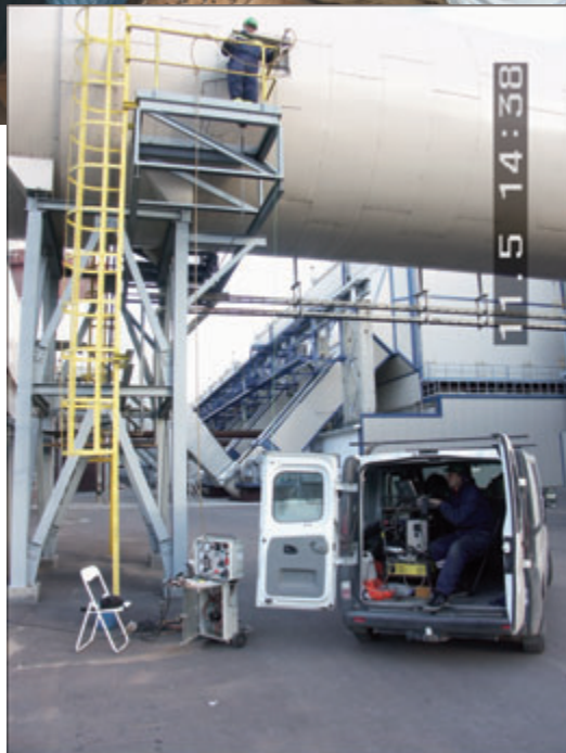
Keevkihtkatelde õhuheitmete määramised Eesti Elektrijaamas
