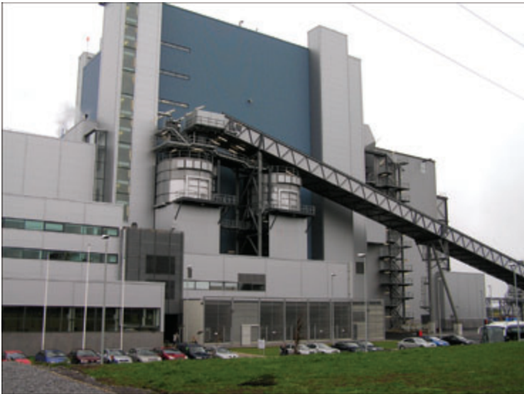
Loch Ree 100 MWe elektrijaam Iirimaa Lanesboroughs
